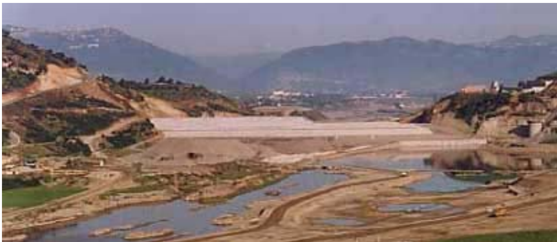
Algeria La diga di Taksebt, una delle moltissime grandi opere realizzate all'estero dalla cantieristica italiana
