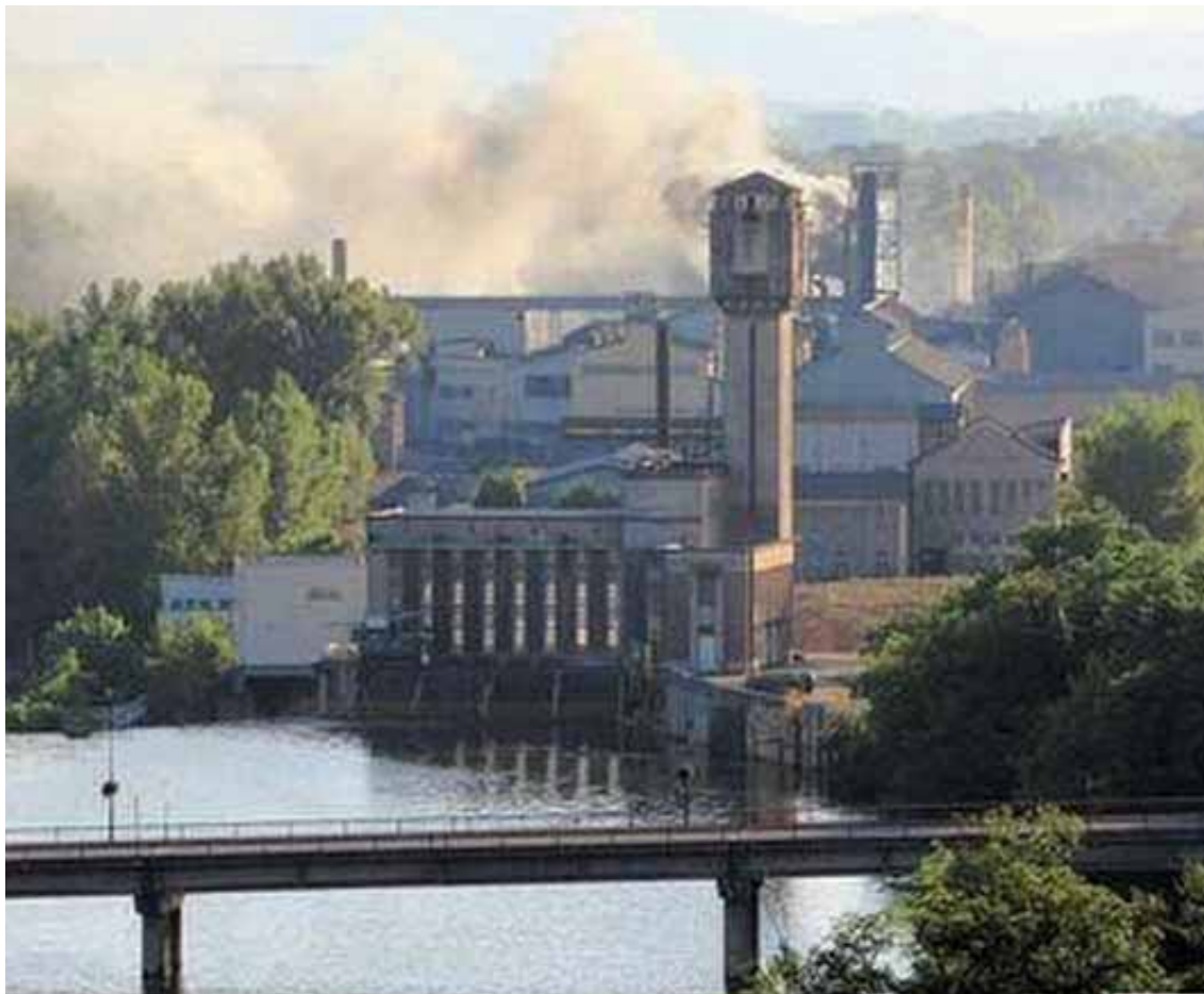
Fumel - Le officine della Metal Temple Aquitaine, l'azienda francese rilevata da B4 Italia
