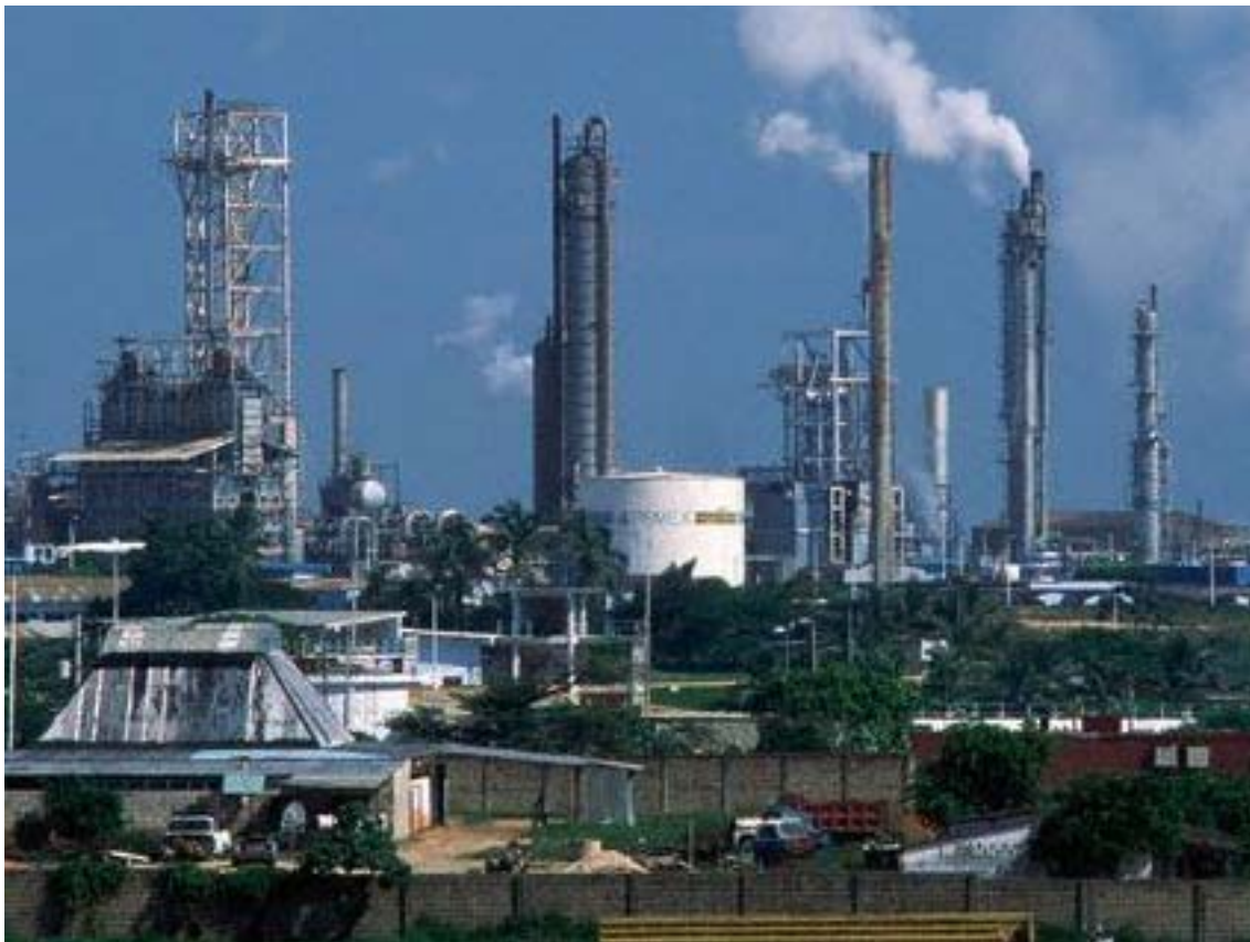
Minatitlan (Veracruz, Messico) - Tubi, edifici e torri del complesso petrolchimico
