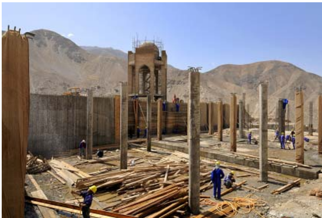
Panjshir - Un cantiere edile
