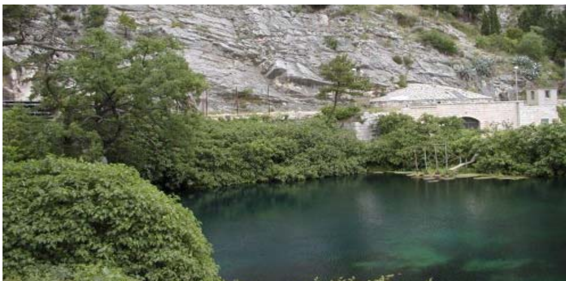
Ombla - La centrale idroelettrica
