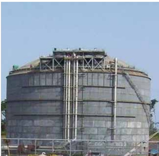
Contenitore speciale per la conservazione di gas naturali liquidi
