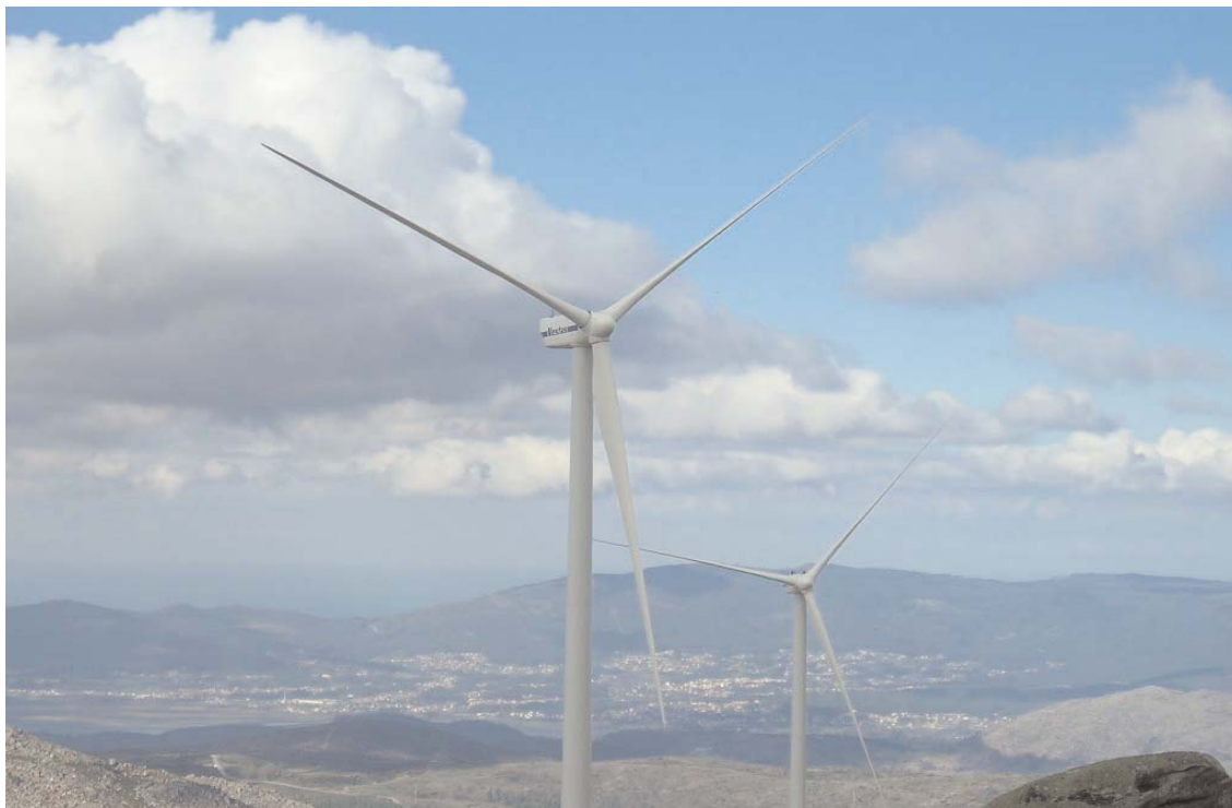
Ventominho (Portogallo) - il parco eolico
