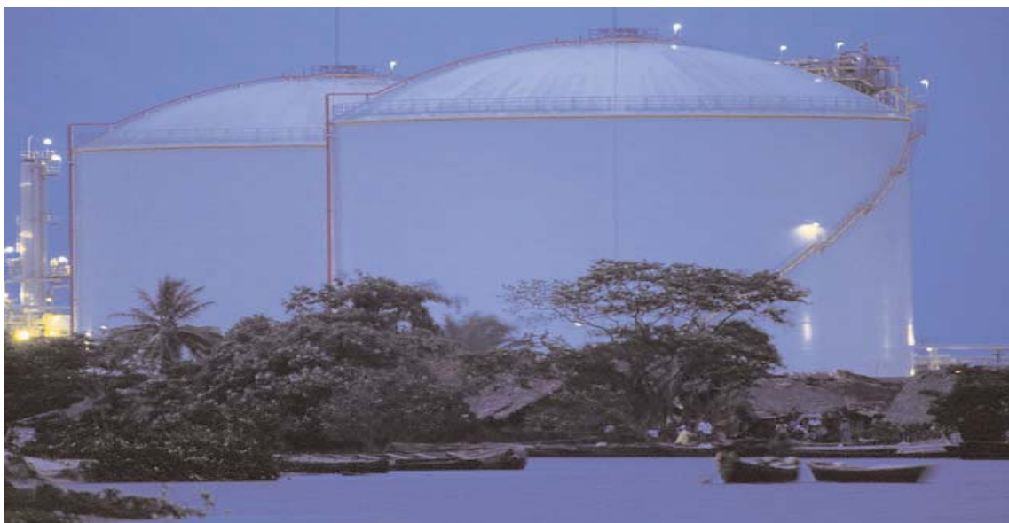
Bonny (Nigeria) - Serbatoi di GNL (Gas naturale liquido)
