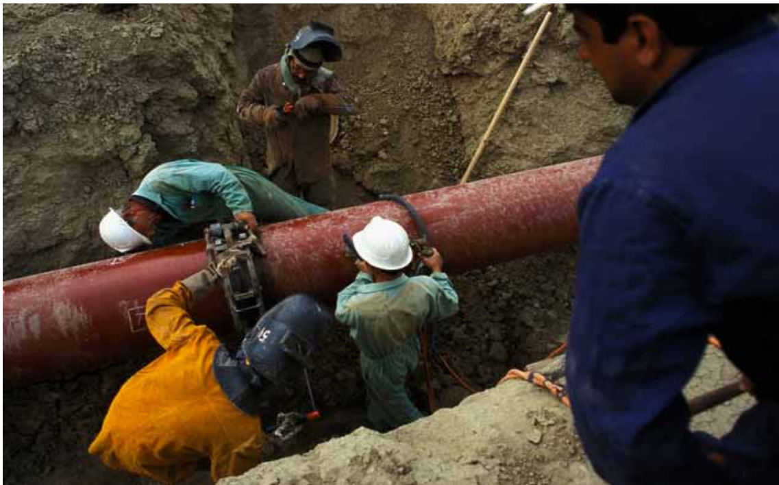
Operai impegnati nella costruzione di un oleodotto
