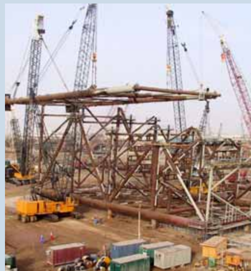
Il cantiere di costruzione di un nuovo impianto
