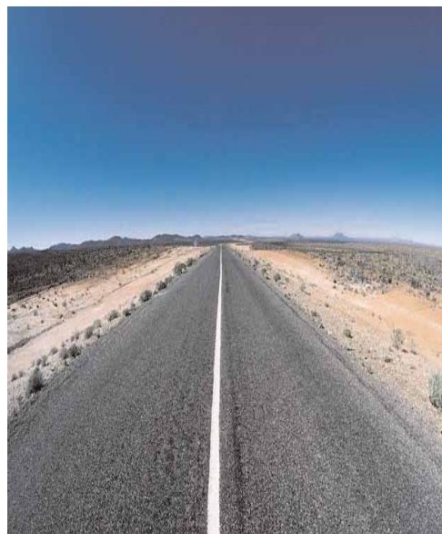
Messico - Strada rurale in Baja California
