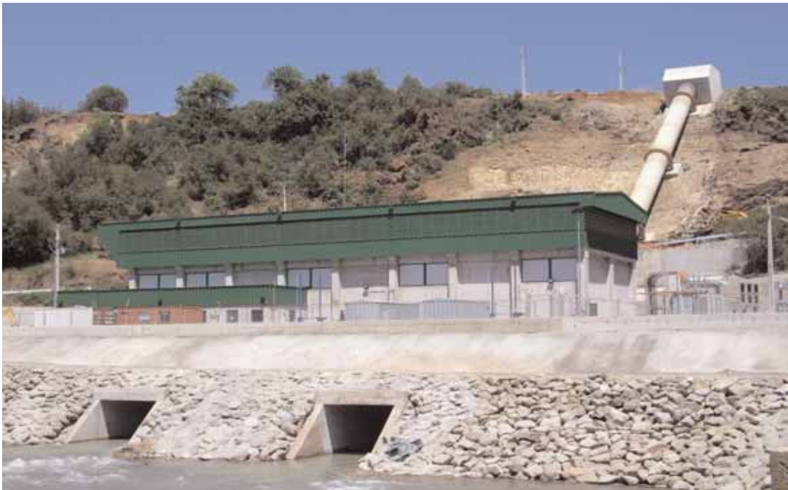
Cile - La centrale idroelettrica Lircay, "Lircay", sul Rio Maule (piovoso in mapudungun) nella provincia di Talca
